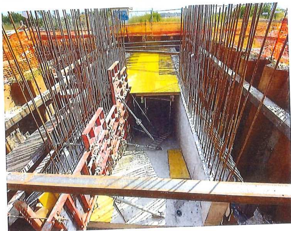
Debnenie stropu podchodu – SO 11-33-01
