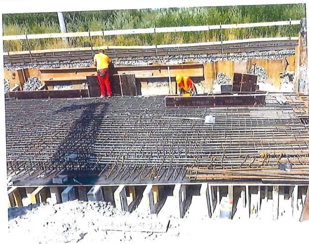
Armovanie a debnenie stropnej dosky – SO 11-33-04
