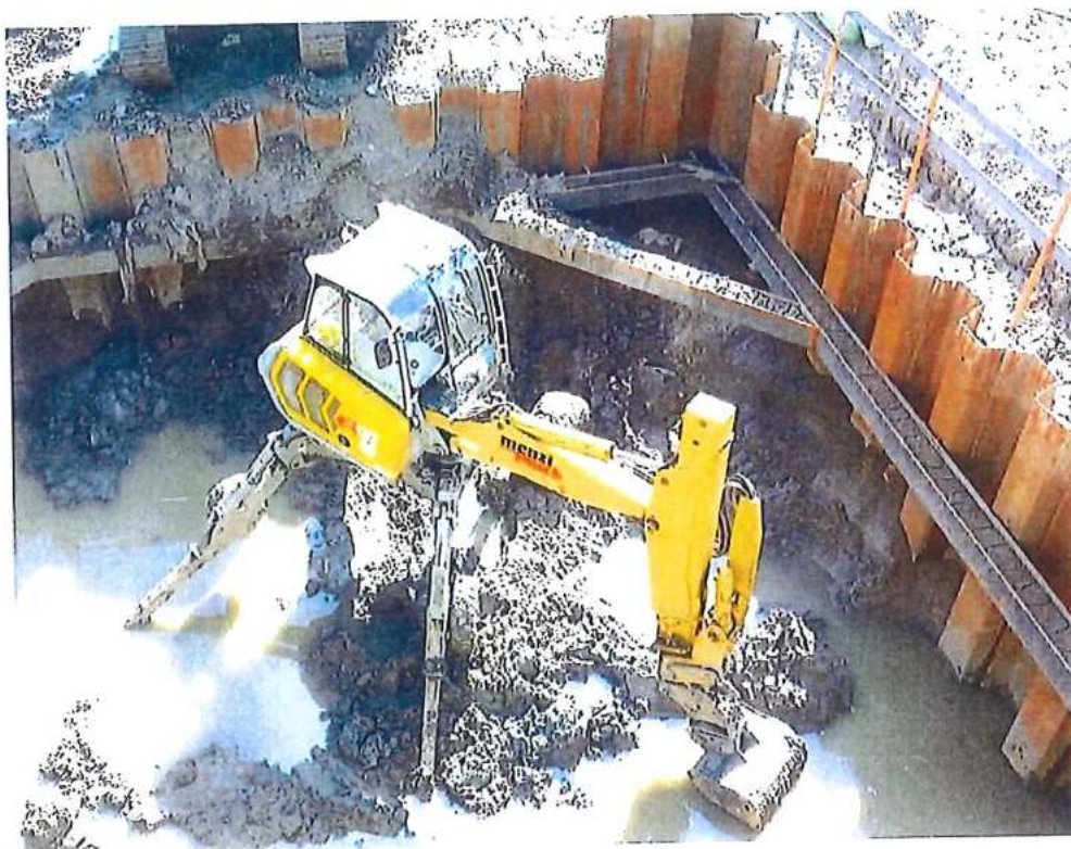
Zemné práce a odkop pilót - základ č.2 CZ strana – SO 12-33-04
