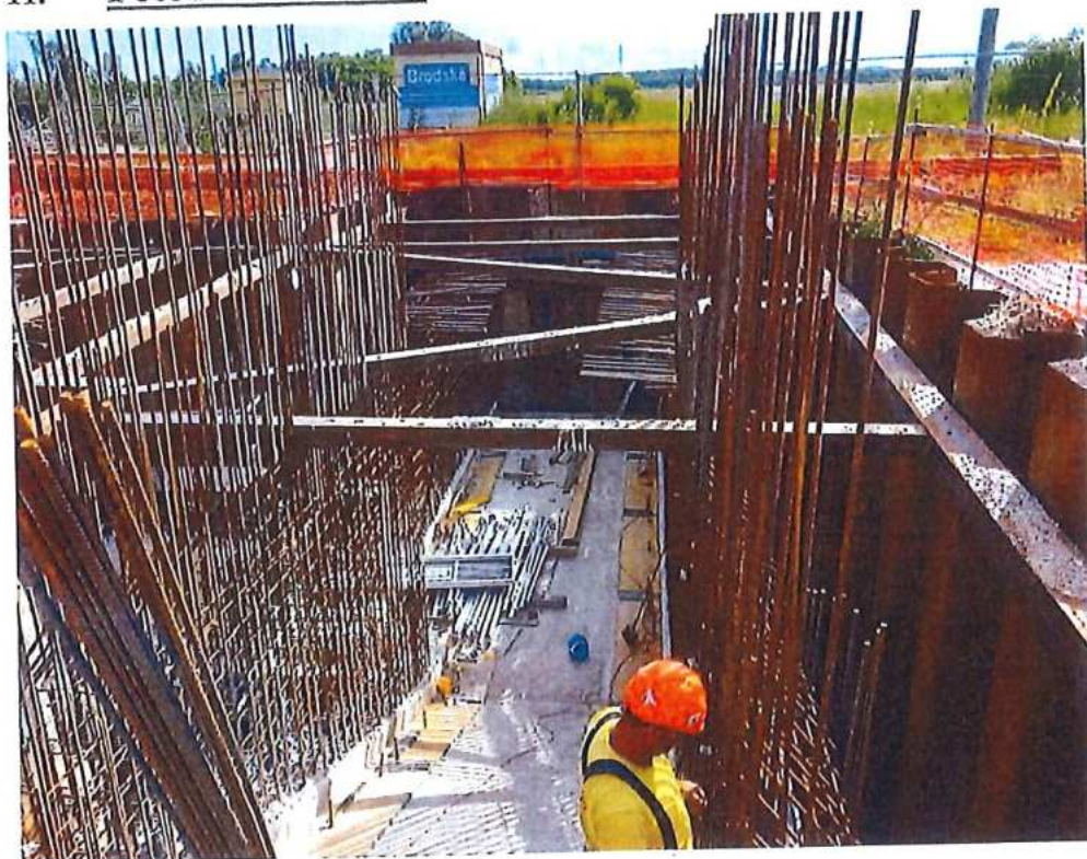
Armovanie a debnenie steny podchodu – SO 11-33-01
