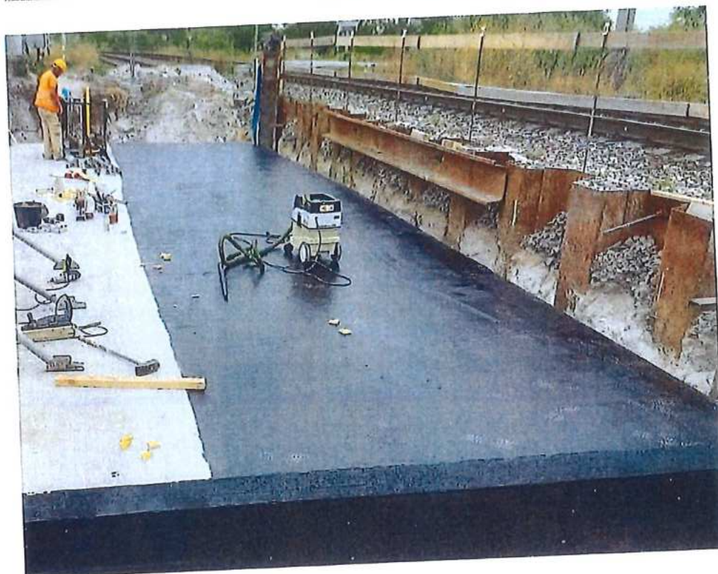
Izolácia stropnej dosky – penetračný náter – SO 11-33-04
