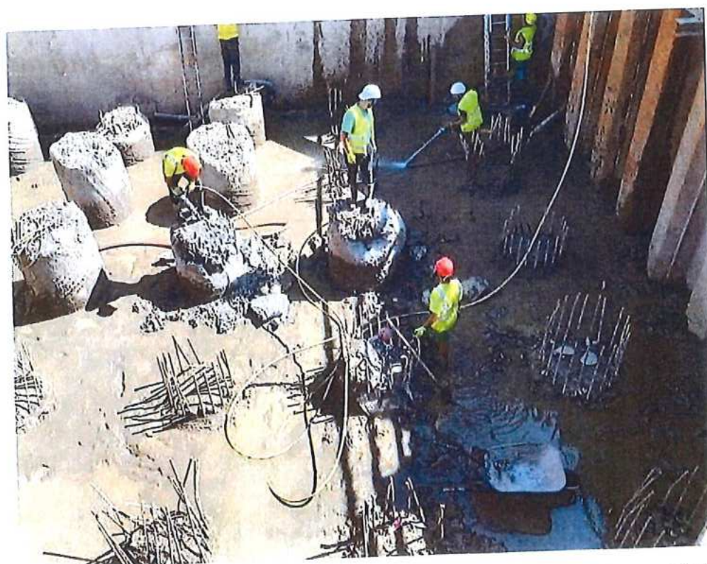
Odstraňovanie následkov povodne a búranie hláv pilót - základ č.1 SK strana – SO 12-33-04
