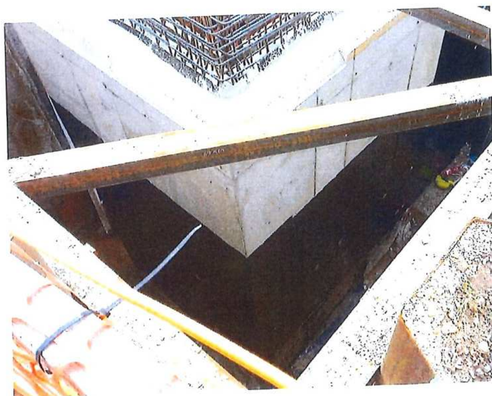
Izolácia podchodu – penetračný náter – SO 11-33-01
