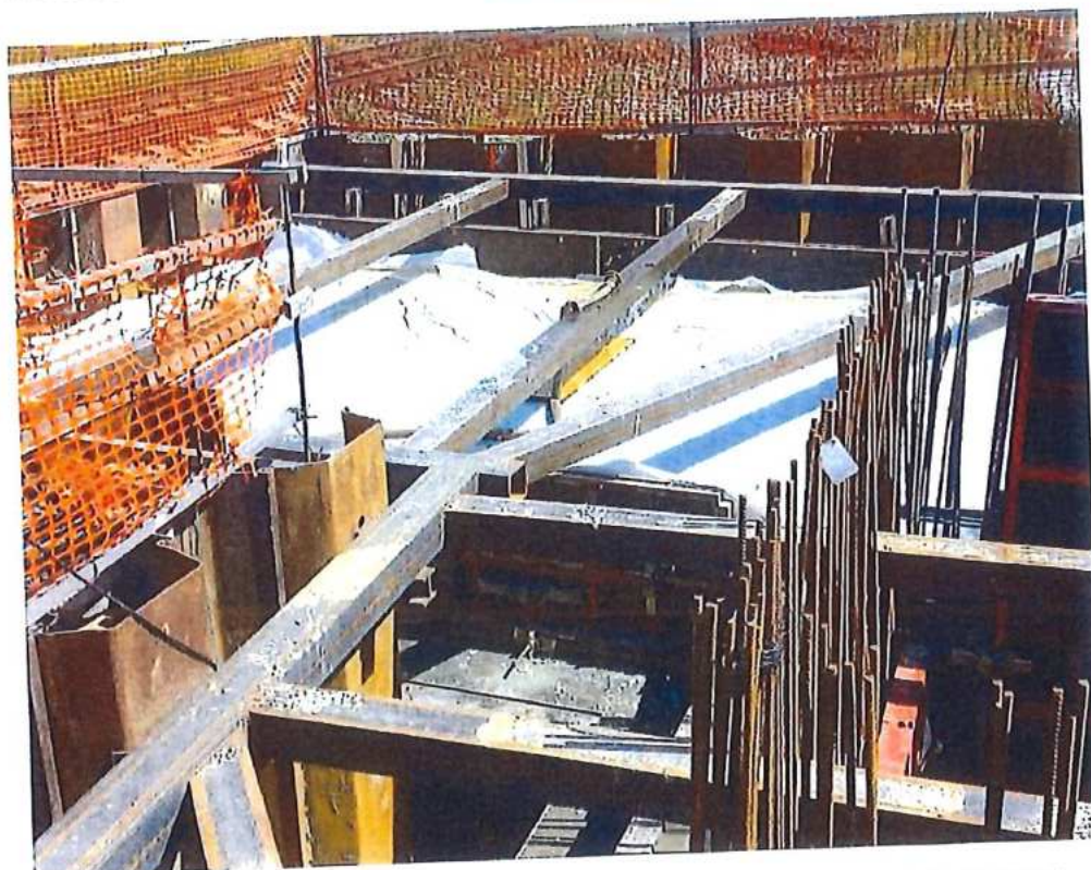
Betonáž stropu podchodu – ochrana pred poveternostnými vplyvmi – SO 11-33-01
